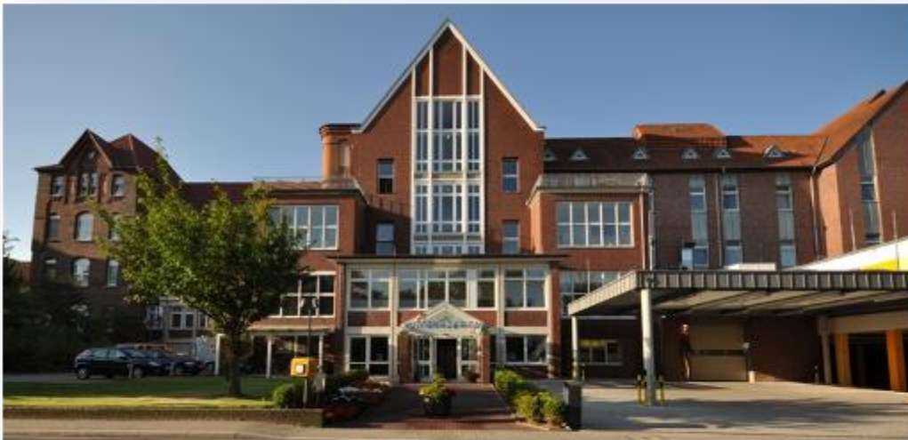
Das Hüttenhospital - Haupteingang
