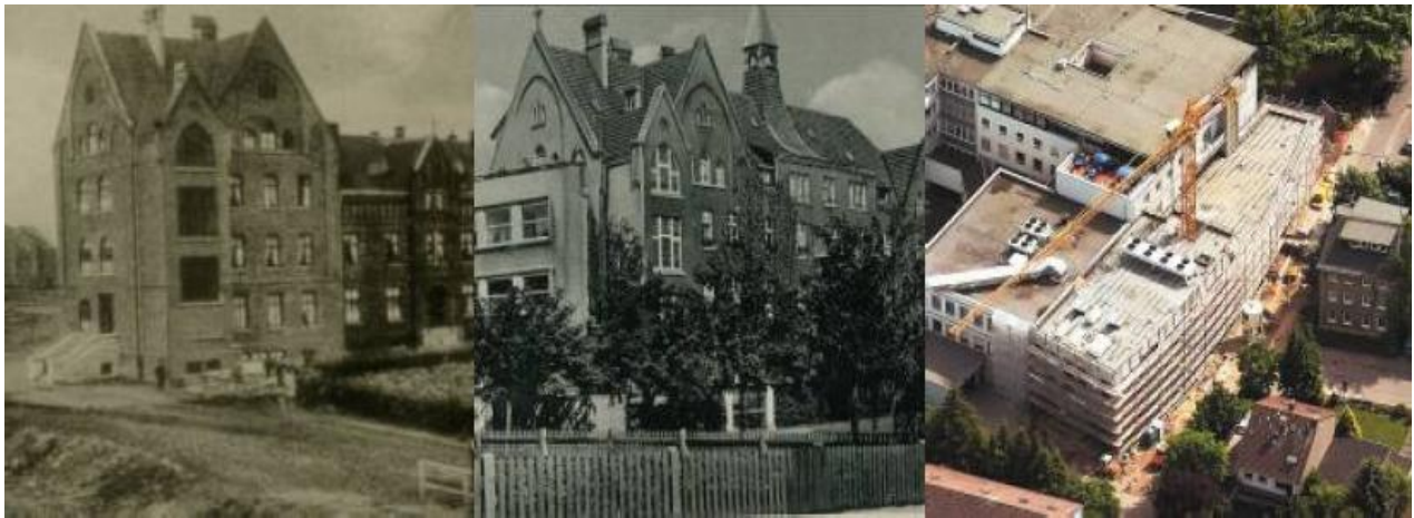
Das Krankenhaus 1906/1907 (l.), nach dem Umbau 1923-1926 und während der Erweiterung 2006.
