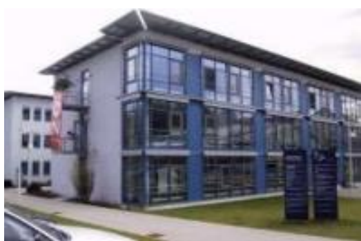
Räume der TK im 2. OG
